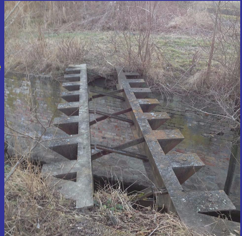
Slika 10 Ostatci željezničkog mosta uskotračne pruge kod Bodorfoka [6]
