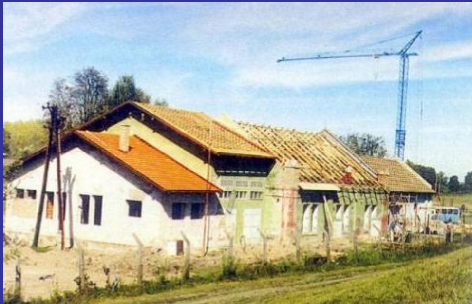
Slika 13. Crpna stanica Zlatna Greda (1980.-tih) [13]
