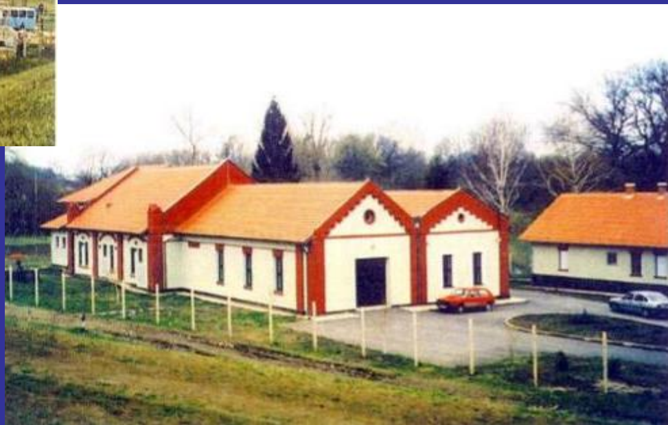
Slika 14. Crpna stanica Zlatna Greda (nakon obnove, 2002.) [13]
